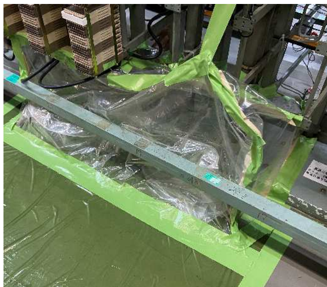
局所隔離の状況
