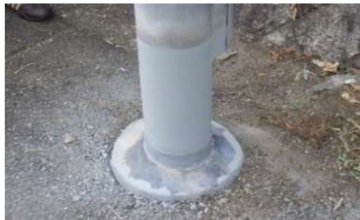
補修後の鋼管柱
