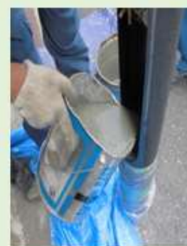
⑤モルタル充填作業
