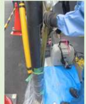
③補修用パックの挿入
