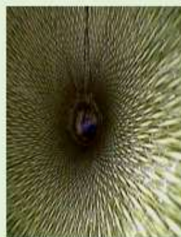
④支柱内の圧着状態
