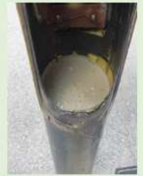
⑥支柱内の充填状況
