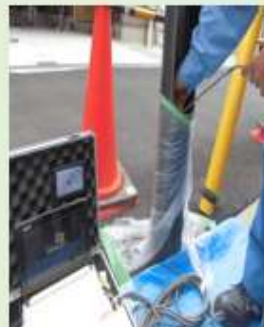
①支柱内の調査等
