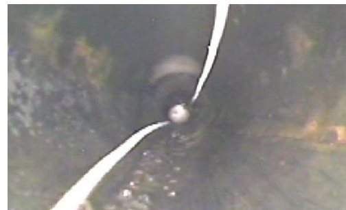
施工後の管路内状況
